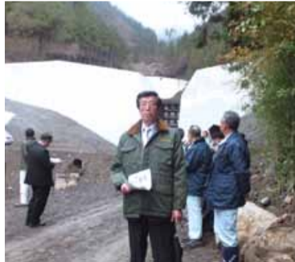
静岡市葵区 坂本地区。透過型堰堤1基を新設。土砂捕捉量6,000m 3 。中央に鋼製スリットを設け、小さな土砂と水は流下させる透過型を採用。事業費1億円。
